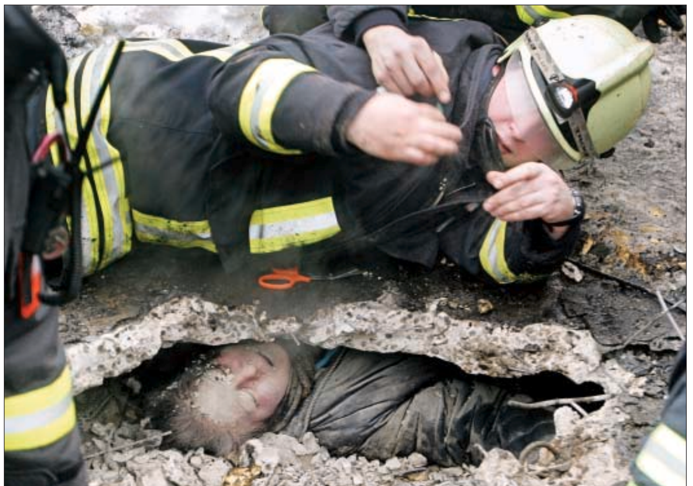
Un equipo de auxilio rescata el cuerpo de una mujer que quedó atrapada por el desplome del techo del céntrico inmueble. La hipótesis principal es que el accidente ocurrió por el peso de la nieve acumulada. Hasta el cierre de la edición se habían recuperado 57 cadáveres y se extrajeron 34 sobrevivientes ■ Reuters
