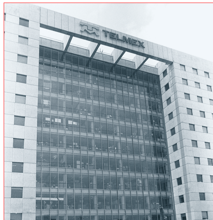
Edificio de Telmex en avenida Parque Vía, en el Distrito Federal. La participación de la telefónica está muy afianzada y la empresa ha mostrado determinación de defender su posición en los tribunales ■ Carlos Cisneros
