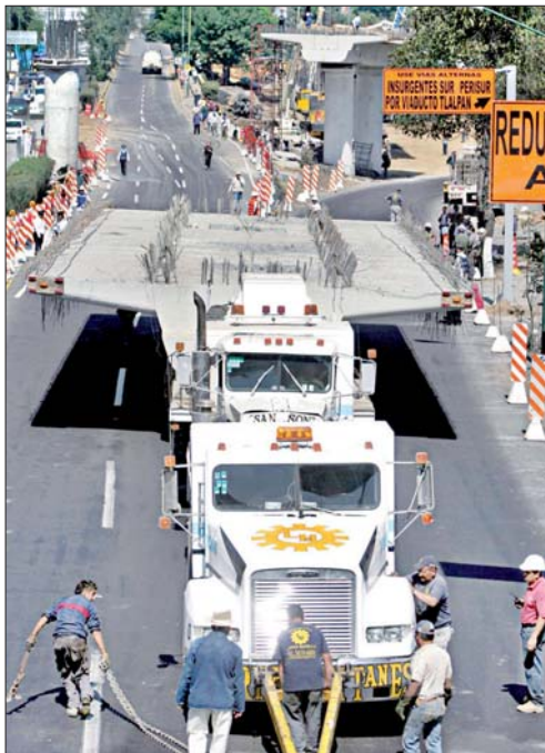
La vialidad en Viaducto Talpan, Insurgentes y San Fernando fue afectada de nuevo por las maniobras de traslado y colocación de traveses para la construcción de un puente. El jefe delegacional en Talpan, Guillermo Sánchez, anunció que hoy habrá un operativo especial de la policía capitalina para evitar otro congestionamiento vehicular ■ Foto Notimex
