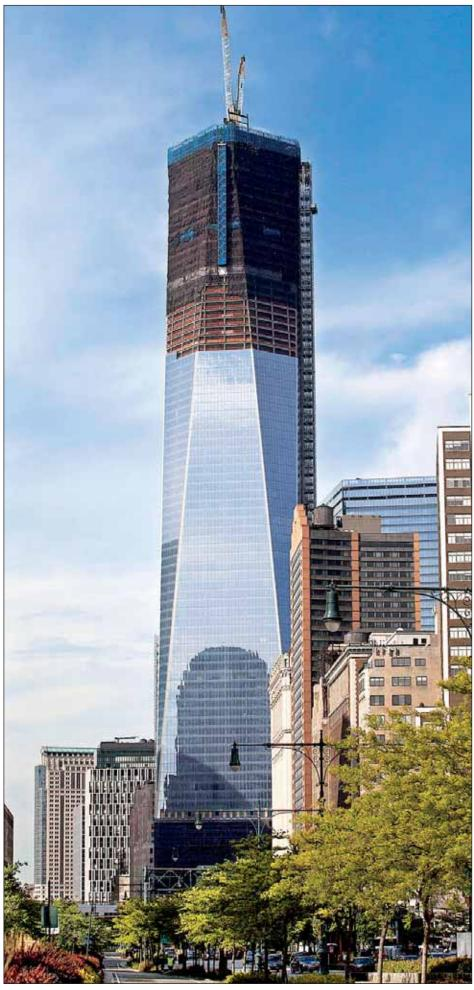
La torre 1 World Trade Center, en construcción en la zona de los atentados del 11 de septiembre de 2001, superó ayer los 381 metros de altura del Empire State Building. Los obreros colocaron una columna de acero en la parte superior del rascacielos, el cual se terminará de construir en 2013, para rebasar esa marca. El inmueble tendrá 104 pisos y 541.3 metros de altura
