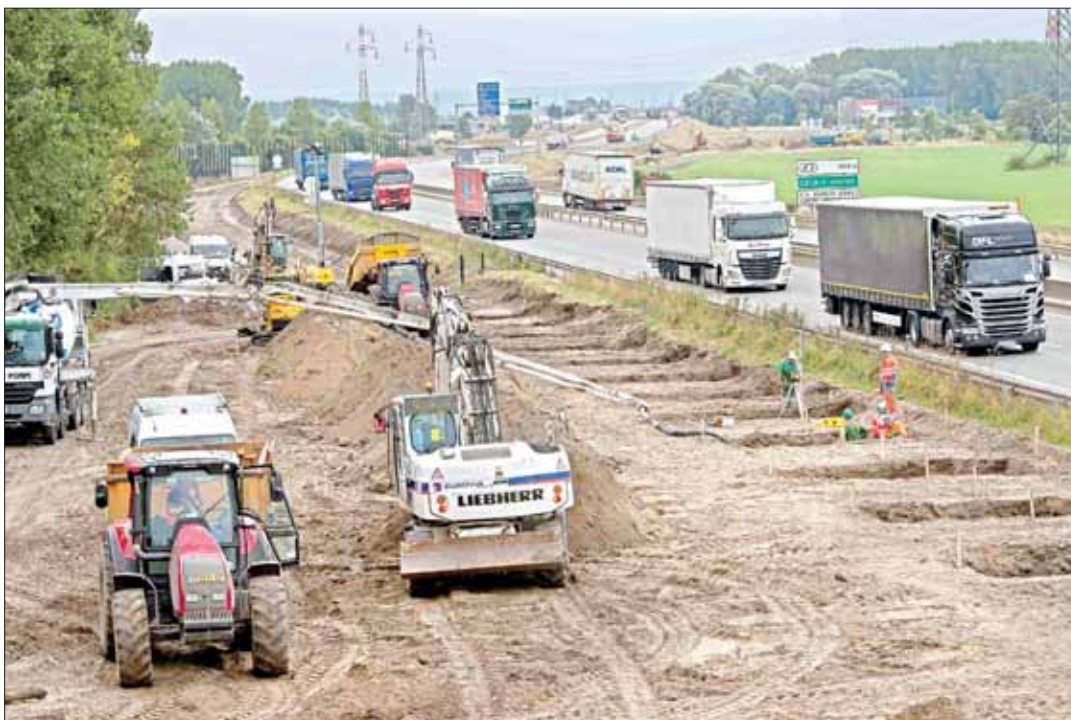
Ayer dio inicio la obra para evitar que migrantes lleguen a ese puerto, en el norte de Francia, desde donde intentan pasar clandestinamente a Gran Bretaña. La valla, financiada por el gobierno británico, tendrá un kilómetro de largo y cuatro metros de altura y está cerca de la llamada Jungla , un campamento donde unos 10 mil extranjeros viven en condiciones deplorables ■ Foto Afp
