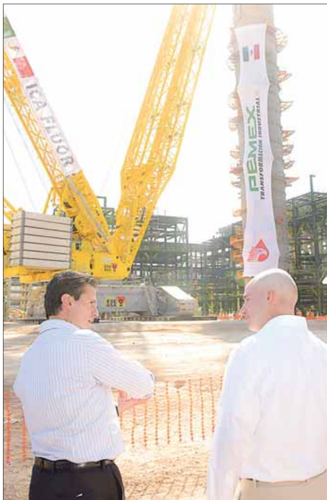
El presidente Enrique Peña Nieto visitó ayer la refinería de Tula, Hidalgo, para supervisar la reconfiguración de la planta de coquización, en la que se invertirán 4 mil 600 millones de dólares. Lo acompañaron los secretarios de Hacienda, Gobernación, Energía y Economía, así como el director de Pemex, José Antonio González (centro) ■ Foto Presidencia
