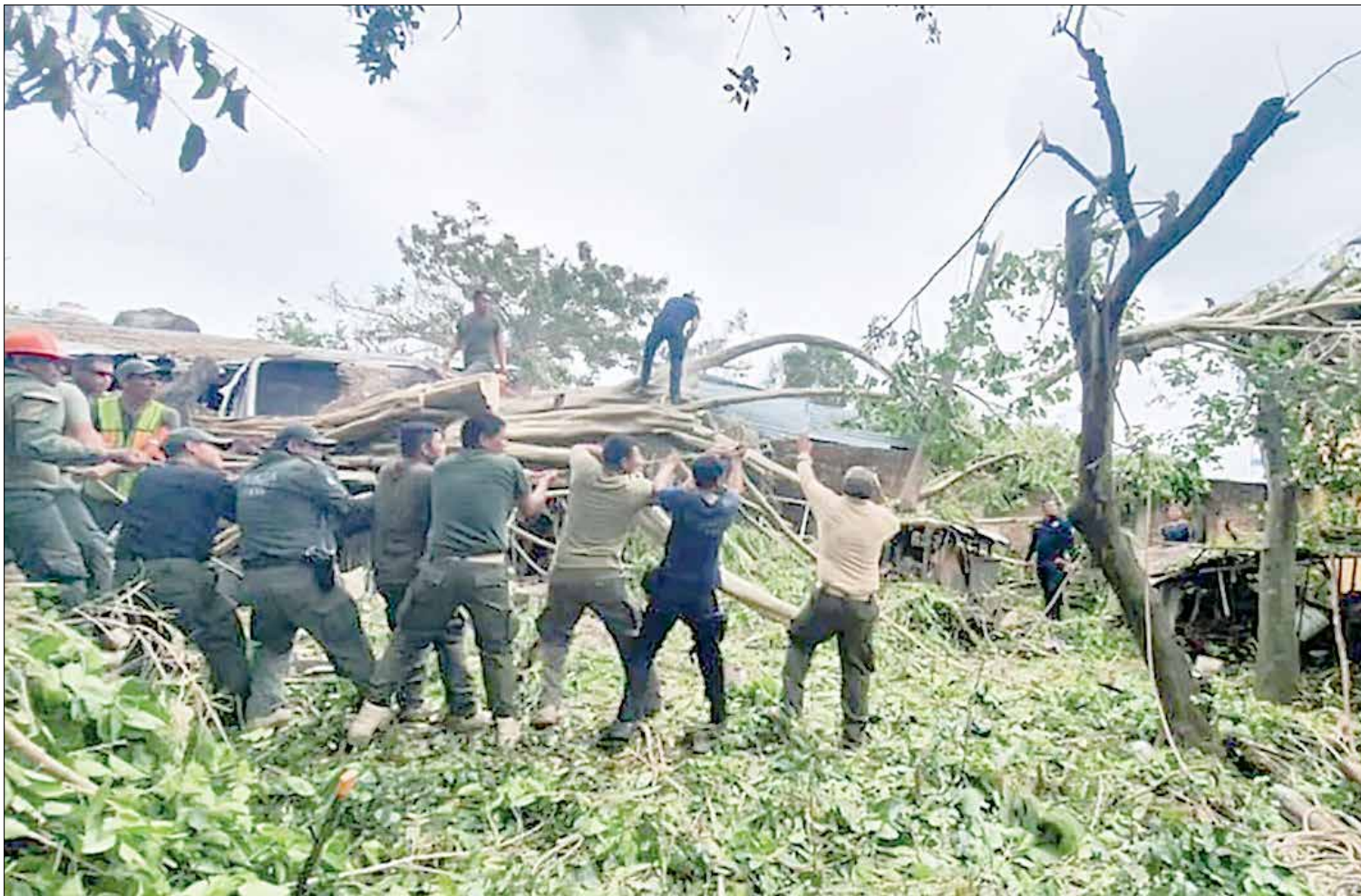
▲ Brigadas de Protección Civil de Veracruz retiran escombros en los municipios más afectados por el huracán Grace el pasado fin de semana, entre ellos Tecolutla (imagen), Papantla, Tuxpan, Poza Rica,
